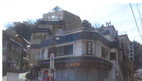
有温泉に施設の改修や一部撤去
