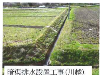
暗渠排水設置工事(川越)
