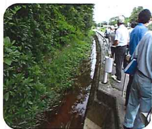
波来浜川河川改修工事予定現場
