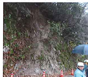
落石対策箇所の視察調査
